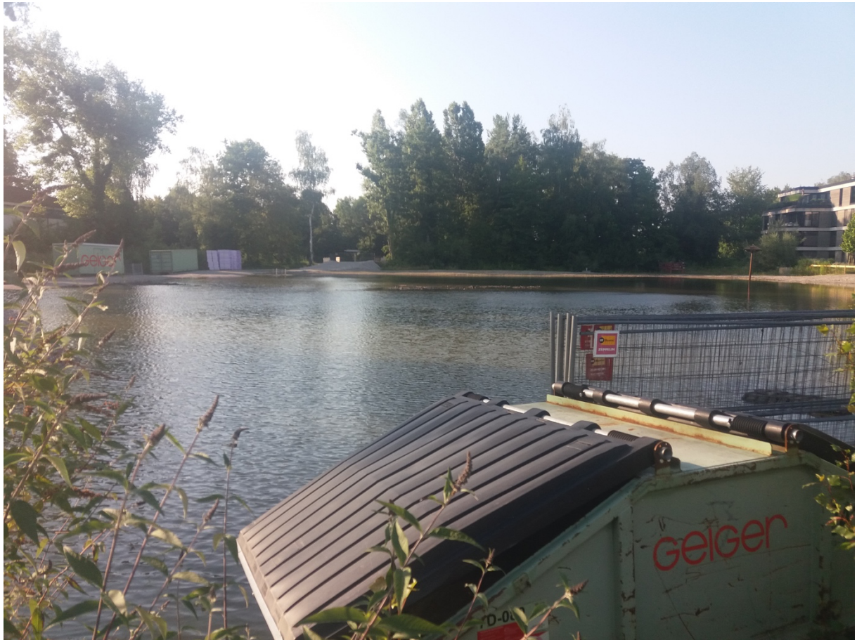
Foto des überschwemmten Bebauungsareals Fläche beim Hochwasser Juni 2024 (Quelle: H.Steitz)
